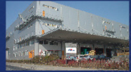
柏ロジスティクスセンター
